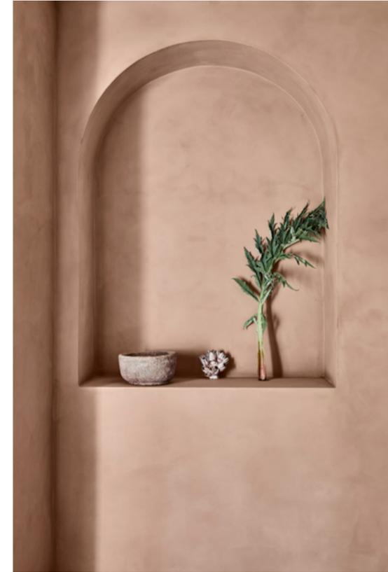
C.A. À la Manufacture, deux artisanes ont appliqué la chaux sur les murs et pas un seul ne se ressemble. Ce matériau a l'avantage de souligner l'ancienneté d'un lieu et donc son authenticité. Il répondait parfaitement à notre travail de restauration : les murs étant isolés à la chaux et au chanvre, les habiller de chaux permettait de continuer à les laisser respirer.
